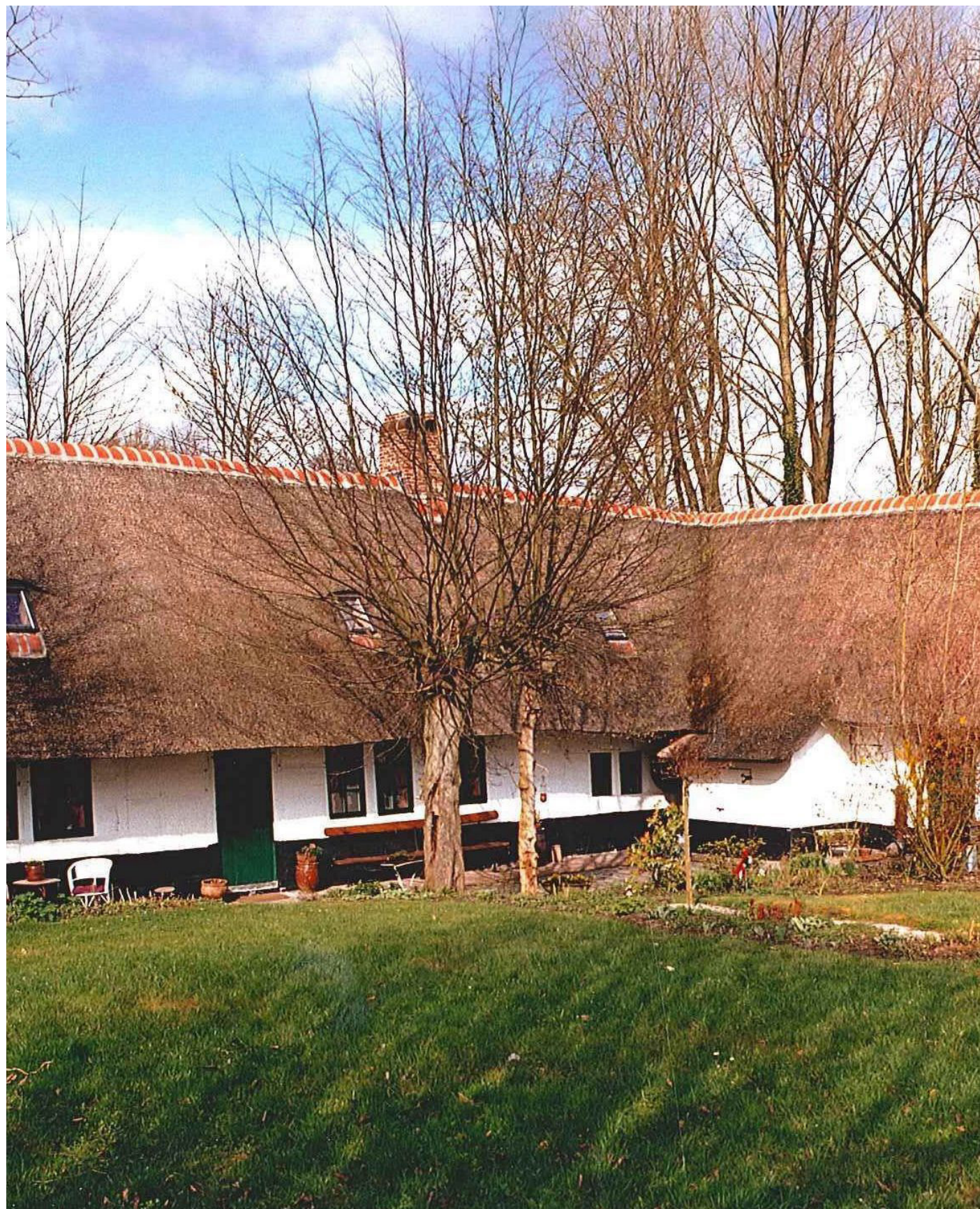
figuur 115 voormalige hoeve in L-vorm in vakwerkbouw met lemen vullingen, Maarkedal (AOE)
