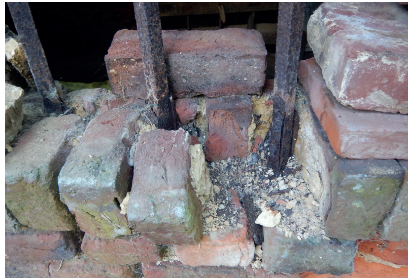
Schade door roestuitzetting.
